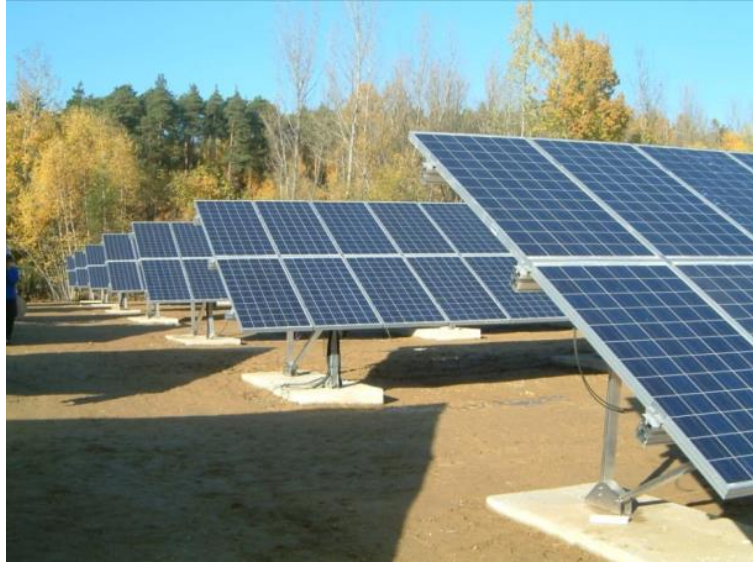
Figure 7 : Exemple de parc photovoltaïque utilisant des longrines en béton
